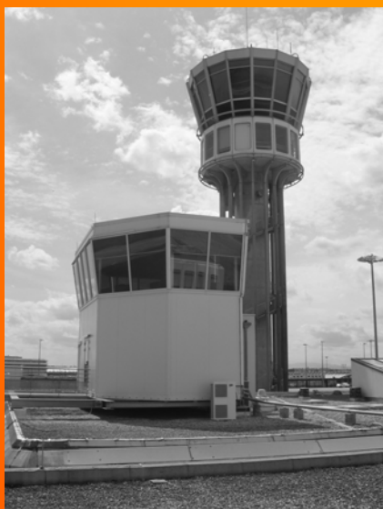
cabine de contrôle sur bâtiment existant
